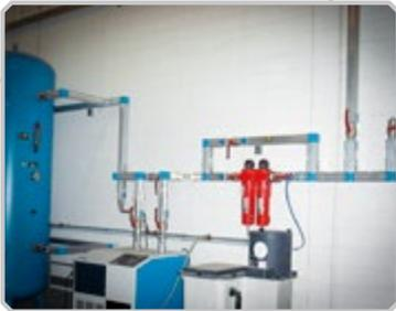
Reti di distribuzione in alluminio per aria compressa, vuoto, argon, azoto, anidride carbonica olii minerali e sintetici e gas non pericolosi e altri fluidi da 20 a 110 mm di diametro interno.
